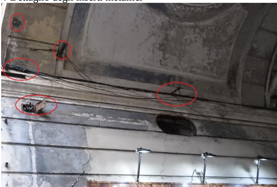
4-Dettaglio degli inserti metallici
